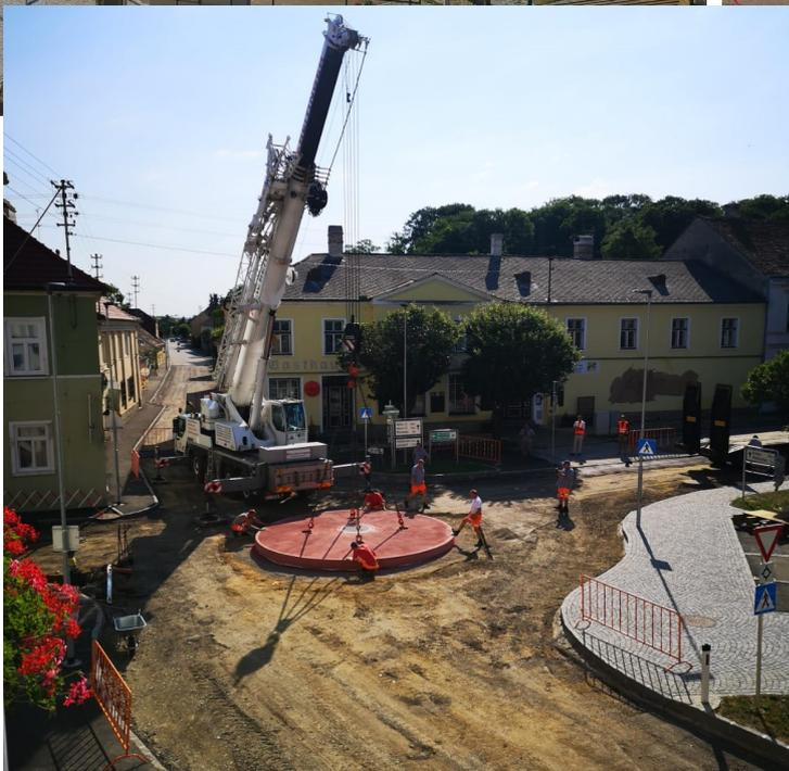
Bilder vom Transport des rot eingefärbten Kreisverkehr-Mittelteils vom Hauptplatz auf den endgültigen Platz in der Mitte des Kreisverkehrs. Die Arbeiten wurden mit Kran und Tieflader-Transport durchgeführt.
