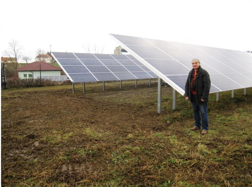
Im Rahmen des Gemeinschaftsprojektes „Sonnenkraft im Schmidatal“ der Klima- und Energiemodellregion Schmidatal wurde bei der Kläranlage Gaidorf eine Photovoltaikanlage errichtet. Die Anlage hat eine Leistung von 46,98 kWp und ergänzt die bereits bestehende Anlage. Mit beiden Anlagen soll ein Teil des Strombedarfs in der Kläranlage abgedeckt werden.
